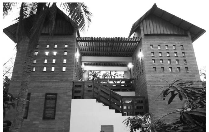
방글라데시 지역에서 구하기 쉬운 대나무와 흙벽돌을 활용하여 지은 본돈(Bondon) 커뮤니티센터 모습.
